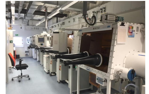
Bsp. Fertigstellung Laboreinrichtung Neuberufung Prof. Blom/Umbau Labore
